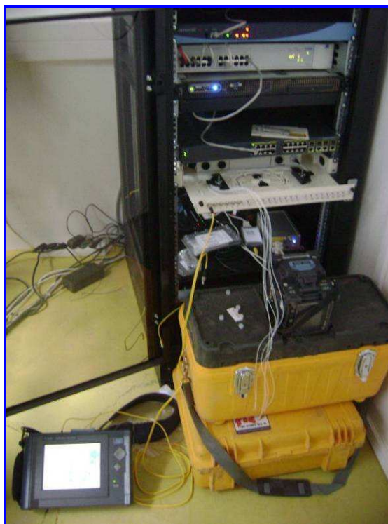
Figura 05. Proceso instalación patch panel OCA
