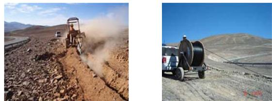
Figura 6. Máquina que realiza la zanja, la fibra es instalada directamente en ésta, se cubre con el mismo material compactado de la excavación.
